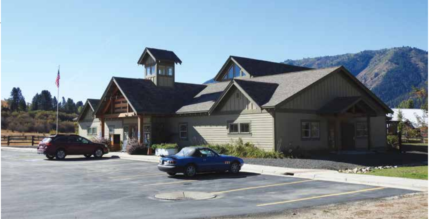
Het gebouw van Garden Valley District Library.
